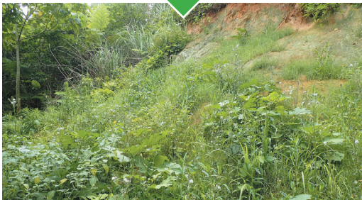
BSC工法で緑が再生（下は施工から3カ月経過時）
